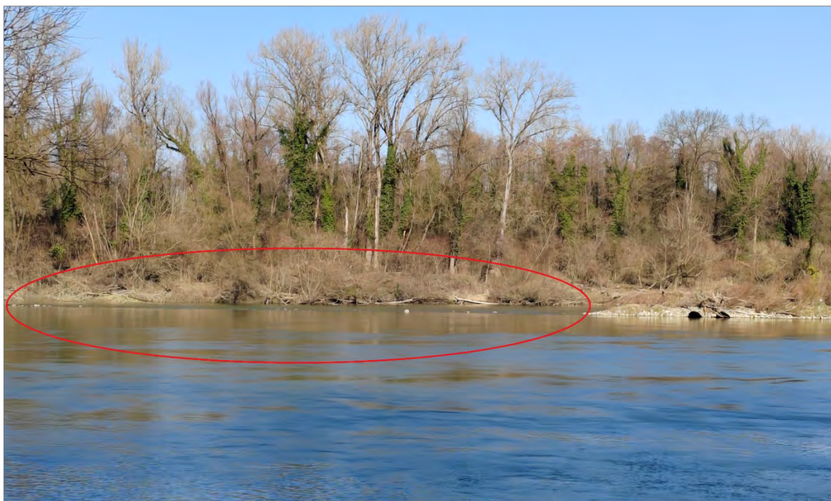
Slika 11. Potopljena pregrada (mađ. Kőgát) na mađarskoj strani rijeke Drave neposredno pred ulazak u postojeći riječni rukavac
